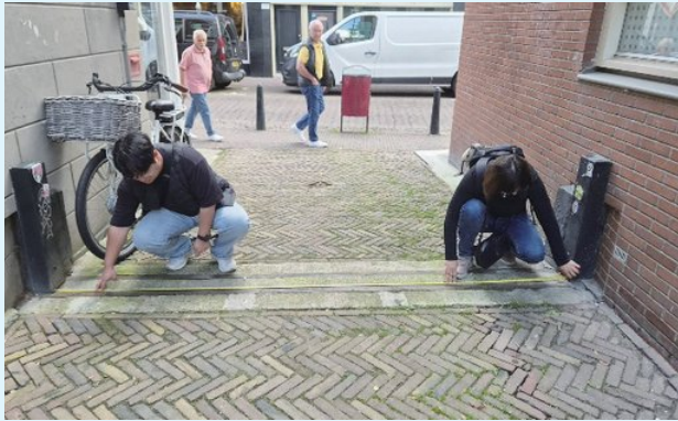
(a) 도르드레흐트 골목 입구의 차수 패널 설치 홈
