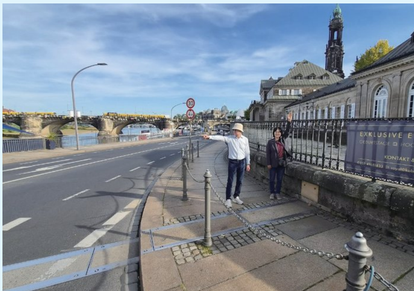
(a) Terrassenufer 단차를 따라 매립된 기초 레일과 옹벽 접속부
