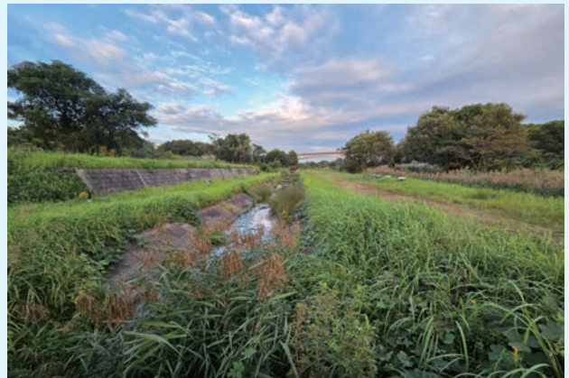
그림 10. ARRC의 호안블록 모니터링 시험 구간
